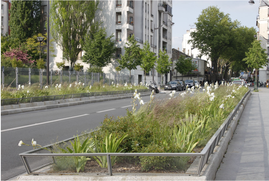
Kuva 44. Esimerkki kalualueen hulevesien imeytysrakenteesta Pariisissa.
